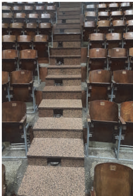
Кріплення під сходами
