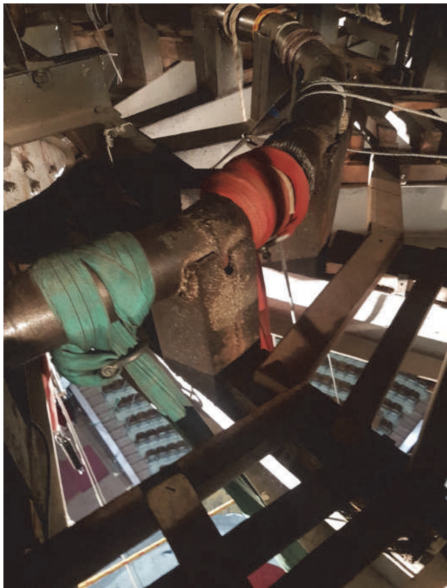
Приклад кріплення строп на колосниках (Рисунок № 16)
