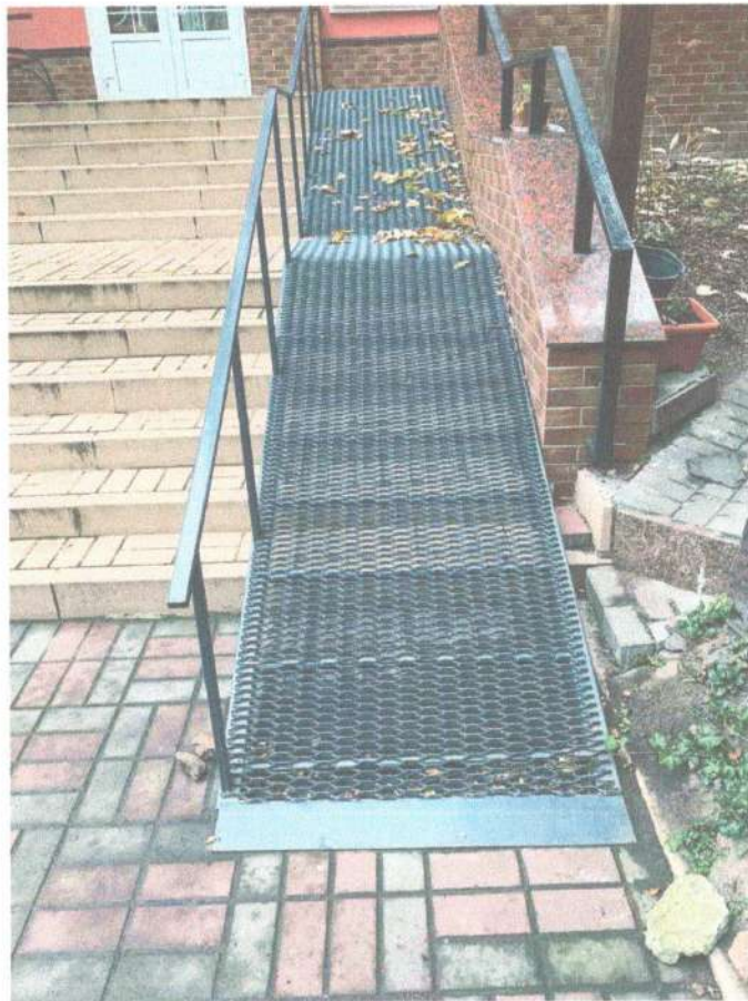
Фото 1 – 2. Загальний вигляд пандуса влаштованого для доступу маломобільних груп населення.
